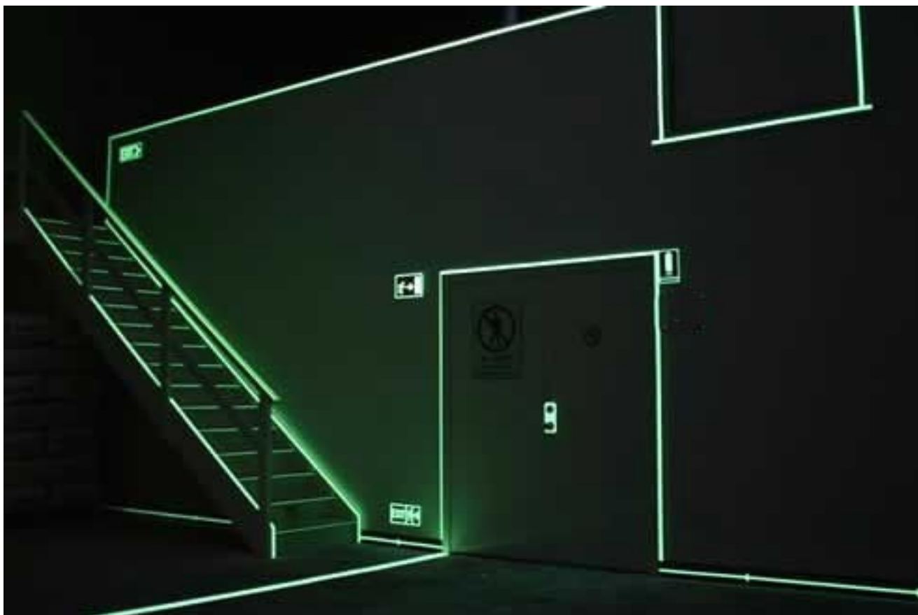
Vue d'un système de guidage photoluminescent en conditions obscure
